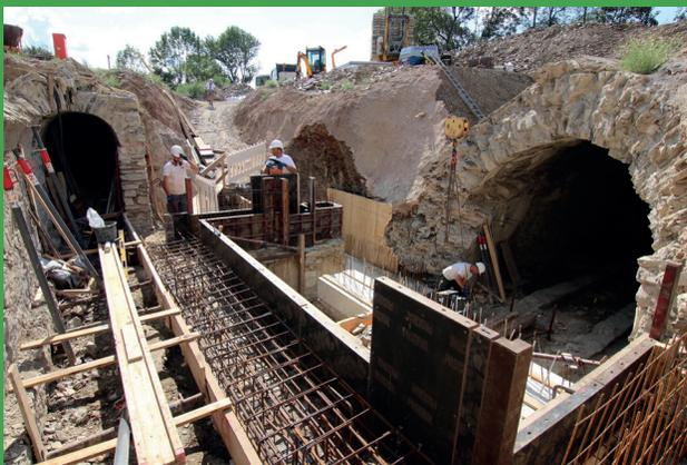
Mit Stahlbeton wurden im September Teile des zerstörten Kriegspulvermagazins rekonstruiert. Ein neuer Notausstieg ermöglicht später eine Öffnung für Besucher.
