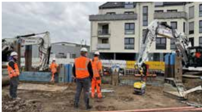
Die Bauarbeiten im Wallersheimer Weg / Ecke Andernacher Str. laufen
